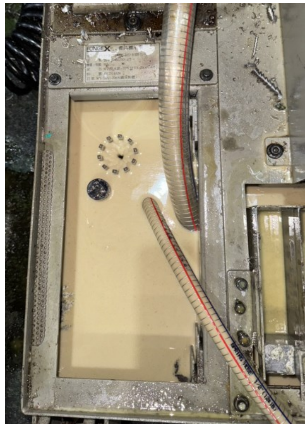
Bildet viser kjølevæsken etter Best1 er benyttet
